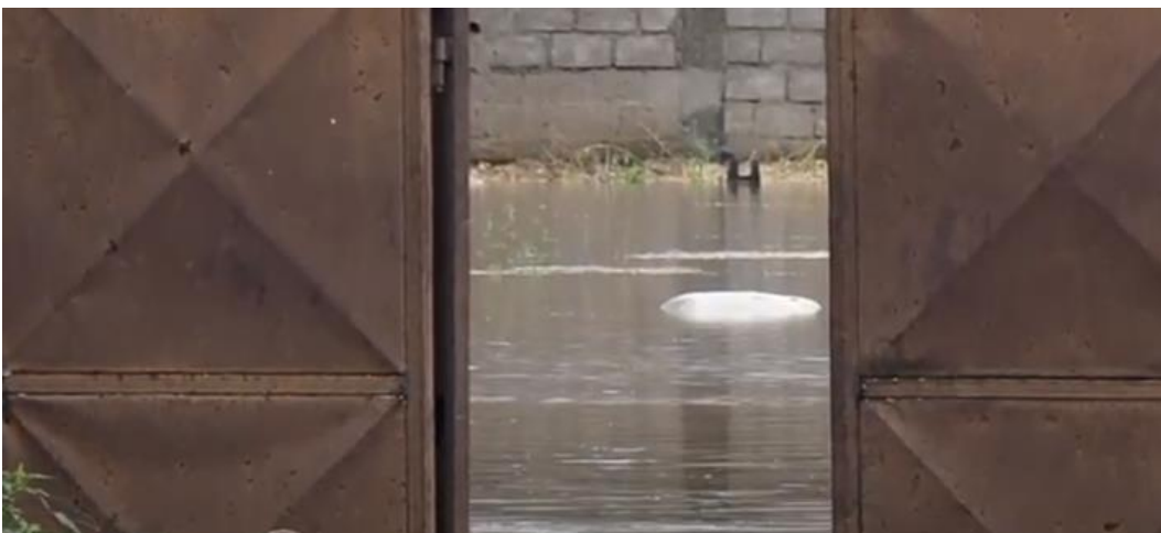
Figure 3 : Inondations d'un hangar se trouvant sur la route menant à l'Aéroport. Ce Hangar constituait un stock de riz à vendre.
